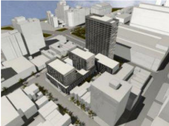
Vue du projet immobilier Le Séville, qui sera situé rue Sainte-Catherine Ouest à Montréal. Photo : Montréal 2025
